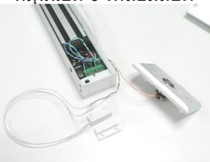
10. ต่อสายไฟเข้า EM Lock Exit, Magnet, Alarm(NC)
