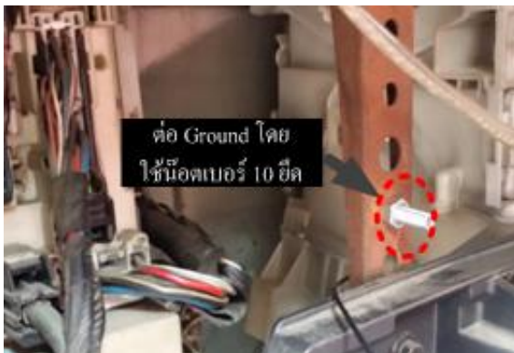
รูปที่ 7. การต่อสาย Ground
