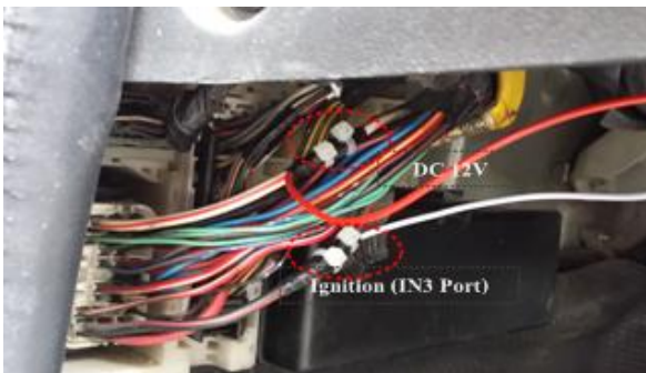
รูปที่ 6. รูปขยายการต่อสาย I/O Cable เข้ากับระบบไฟรถ
